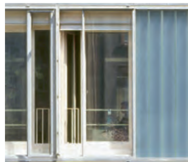
Fassadenausschnitt Kastenfenster; Zentrum Verkündigung, Frankfurt am Main (Bockenheim)
