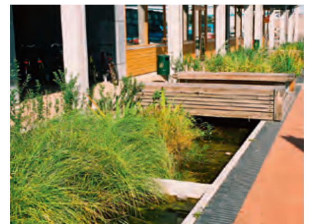
Beispiel: Rückhaltebecken bzw. Graben
