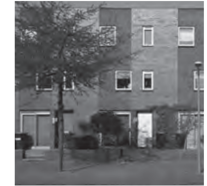
Erhöhter Vorbereich, Kop van Zuid, Rotterdam; DeZwarteHond
