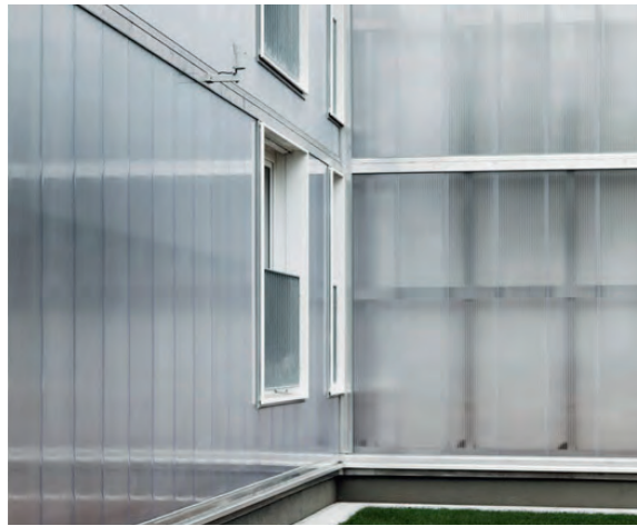
Beispiel: Fassadenluftkollektor; Fassadenausschnitt Punkthaus, Mannheim
