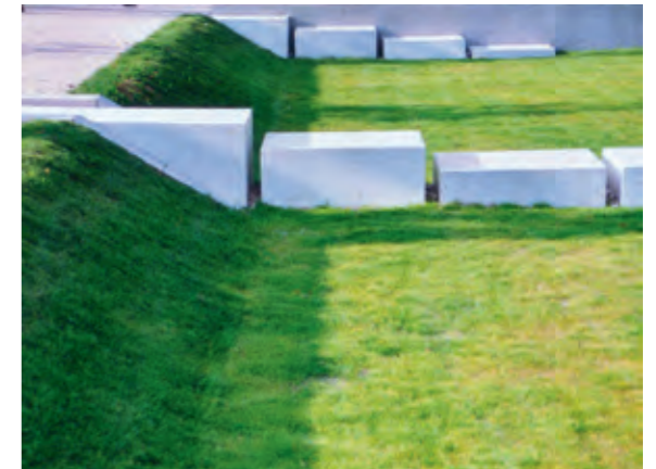
Beispiel: Muldenwiese, Scharnhäuser Park, Ostfildern; Atelier Dreiseitl
