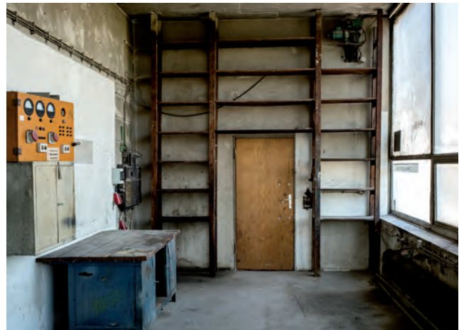
Fotos oben: Ali Altschaffel, 2013, Foto rechts: Ali Altschaffel, 2019
