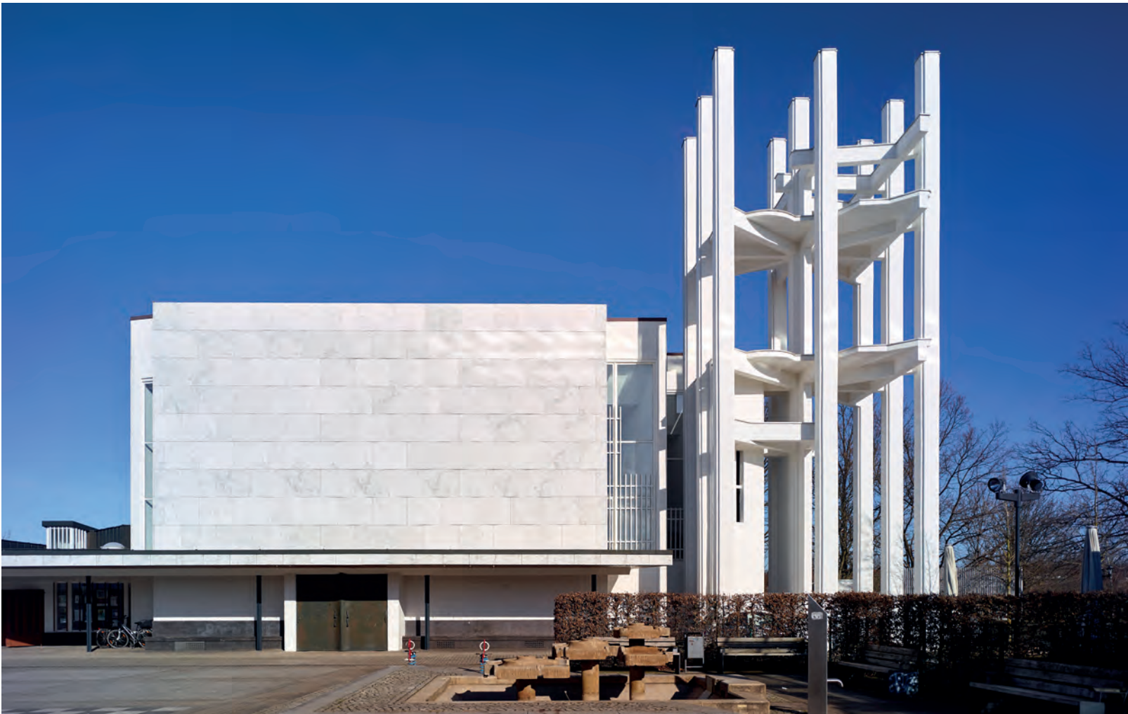
Stephanuskirche und Gemeindezentrum, Südfassade am Marktplatz Stephanus church and parish centre, southern façade on Marktplatz square Foto: Tim Dalhoff
