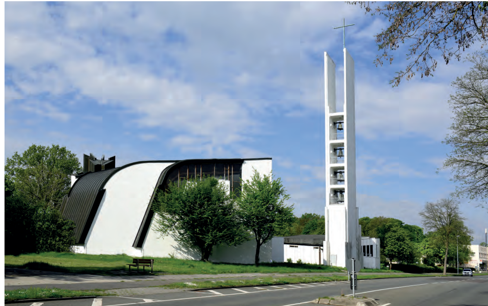
Heilig-Geist Kirche, Ansicht von Osten Heilig-Geist church, view from the east Foto: Lars Landmann
