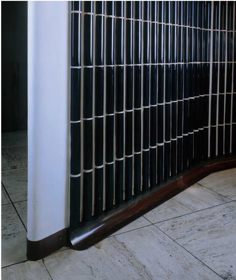
Alvar-Aalto-Kulturhaus, Nordfoyer, Keramikverkleidung und Kupferkehlung zwischen Wand und Boden Alva-Aalto-Cultural-Centre, north foyer: ceramic tiling and copper skirting between wall and floor Foto: Jutta Brüdern
