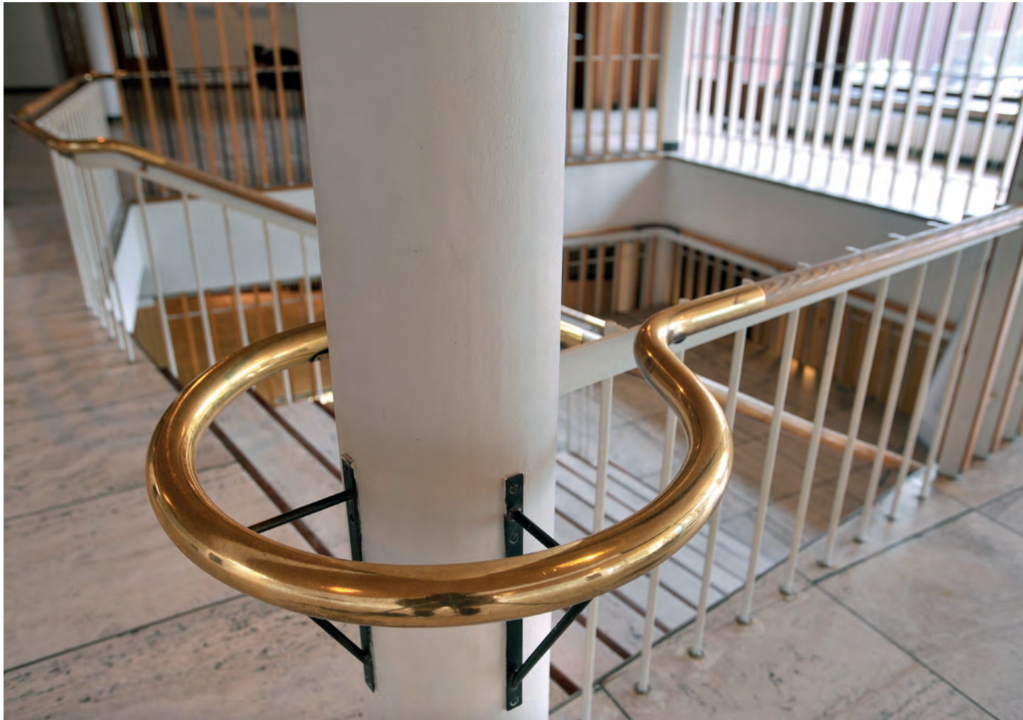
Alvar-Aalto-Kulturhaus, Oberes Foyer, Handlauf der Haupttreppe Alvar-Aalto-Cultural-Centre, upper foyer: handrail on the main stair Foto: Lars Landmann
