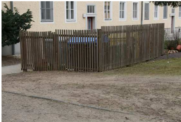
Müllcontainerverkleidung: links: Rilkehof
