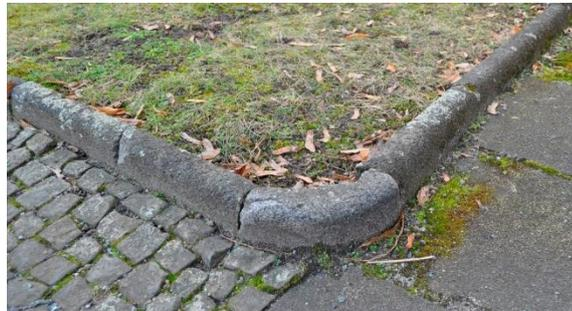
Abbildung 29: Kantenstein, Rundprofil und „runde“ Ecke
