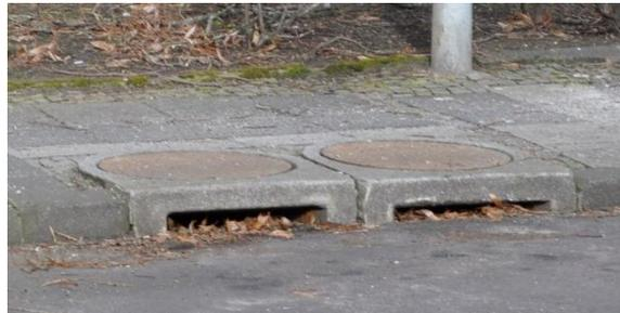
Abbildung 31: Seitlicher Regenwasserabfluss
