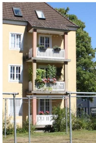
Abbildung 19: Balkone in Massivbauweise mit Holzbrüstung, Roseggerstraße 10
