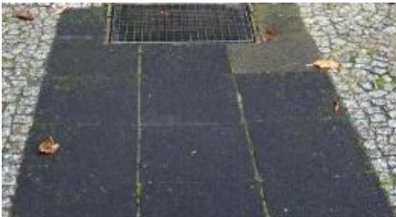
Abbildung 28: Betonplatten 30 cm x 30 cm
