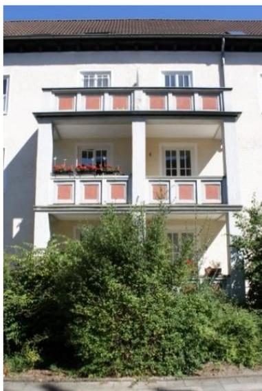
Abbildung 18: Balkone in Massivbauweise mit gemauerter Kassettenbrüstung, Scheffelhof 4+6
