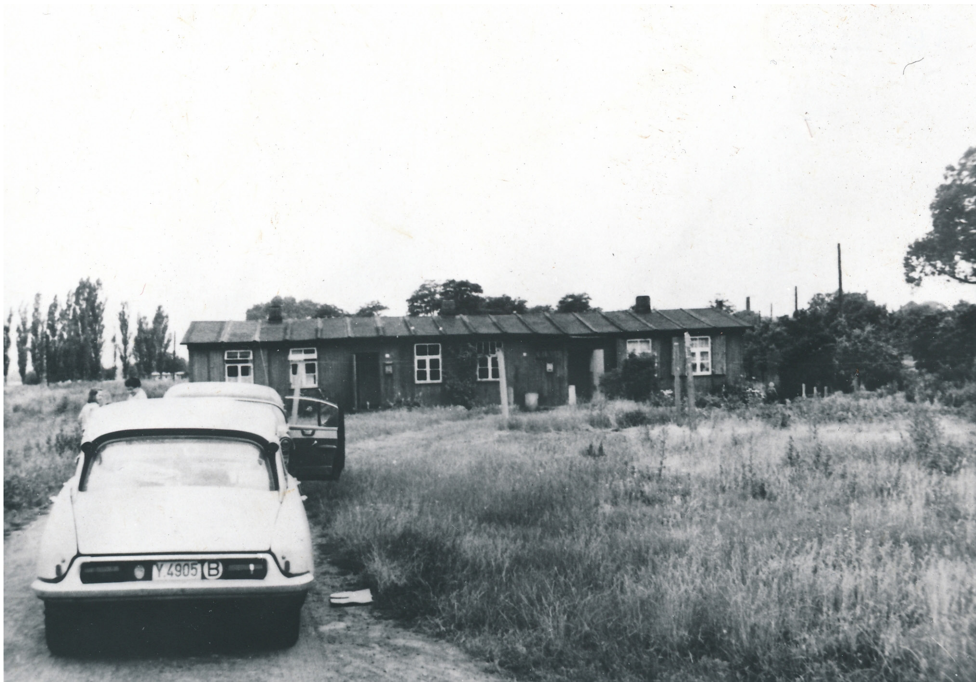
Abb. 2: Ein Fahrzeug aus Belgien vor einer Baracke in Sandbostel, September 1960; Foto: unbekannt/KZ-Gedenkstätte Neuengamme, F 1981-78
