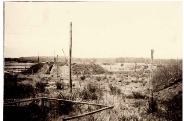
„In der Flakstellung Schillerteich werden Laufgräben von den Geschützstellungen zu den Munitionsbunkern gegraben.“
