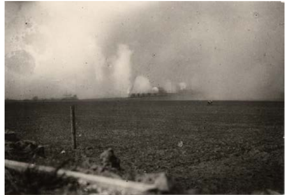
„Künstlicher Nebel soll das Werk vor Feindsicht schützen. Aufnahmestandort: Geschützstand Laagbergstellung in Richtung Mittellandkanal (Tor West/Süd? des Werkes).“
